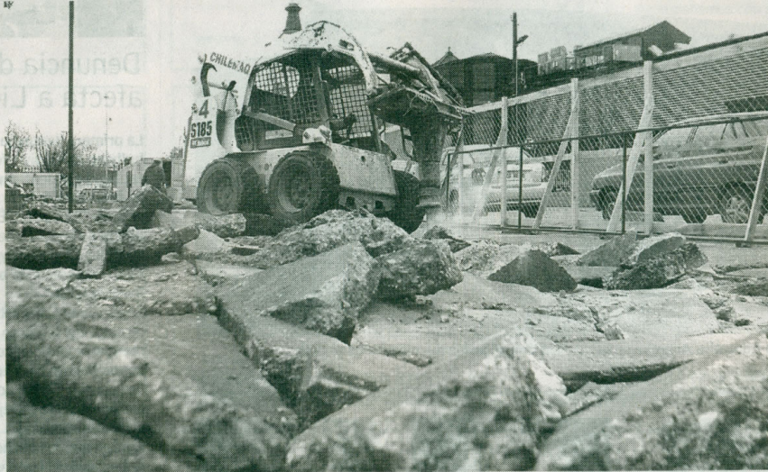
Las máquinas excavadoras demuelen los cementos de la antigua costanera.
